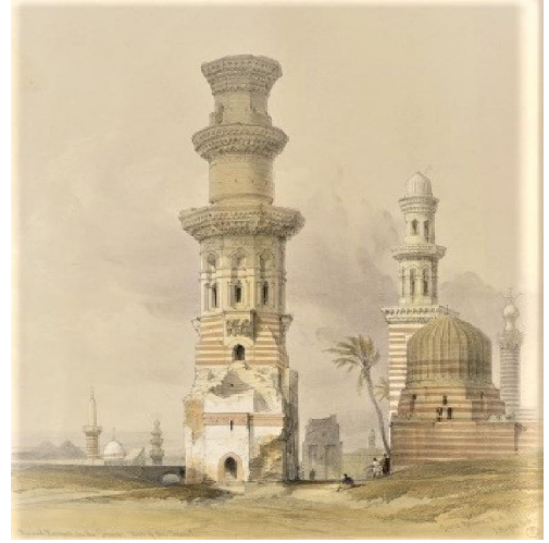
لوحة رقم ١٨ قرافة السيوطي، ويظهر بها سقوط قمة المئذنة القبليّة. عن ديفيد روبرتس، مصر والنوبة.
