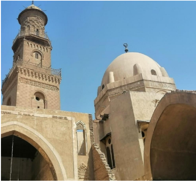
لوحة رقم ٨ تقدم قبة قلاوون للمئذنة، مما يساعد في صد جزء من تيارات الرياح عنها. تصوير الباحثة.
