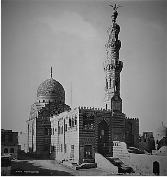
لوحة رقم ٣١ منذنة مدرسة السلطان قايتباي، ويظهر بها سد المسافات بين جوسق المنذنة. عن http://www.flickr.com/photos/photohistorytimeli
