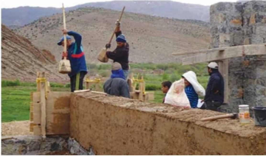
شكل رقم (٧) صورة لصناعة الجدران والحوائط بطريقة المداميك الخشبية ١ .
