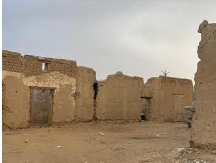
لوحة (٢١) الواجهة الخارجية لمجموعة البيوت السكنية. (تصوير الباحثة بتاريخ ١٥-١٦/٩/٢٠٢٣ م). ١
